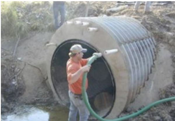
Solução de reforço da PH de Calvelos com recurso a tubo de PRFV
